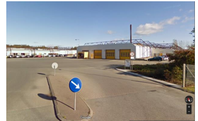
Busdepot Syd: Jegstrupvej 5, 8361 Hasselager
